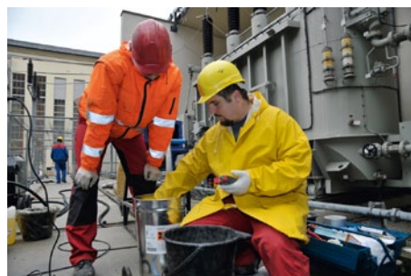
Temperaturmessung des Harzes.
