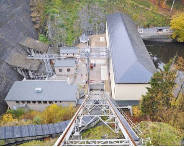
Bleilochtalsperre – ausgestattet mit dem neuen Schlauchliner von Trelleborg.
