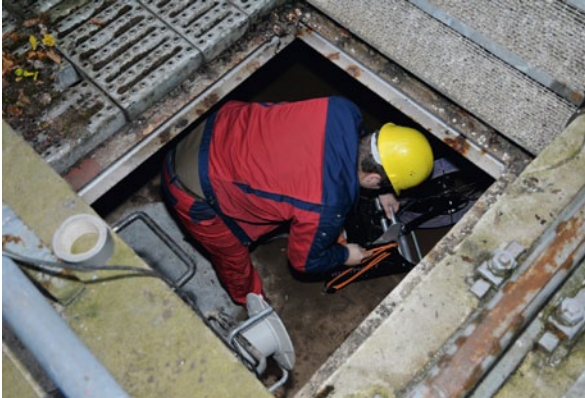
Kanalbefahrung zur Feststellung des Sanierungsausmaßes.
