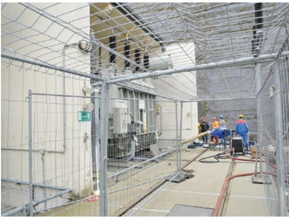
Der Faradaysche Käfig als Schutz vor Hochspannung.
