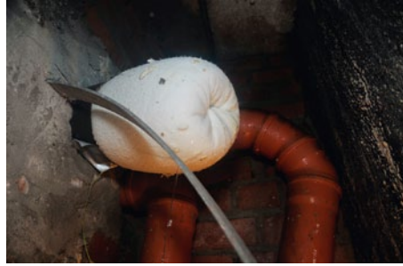
Nach der Inversion: Schlauchlinerende im Schacht.
