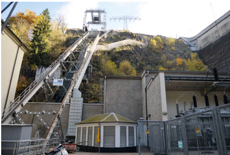
Die Baustelle unterhalb der Staumauer.
