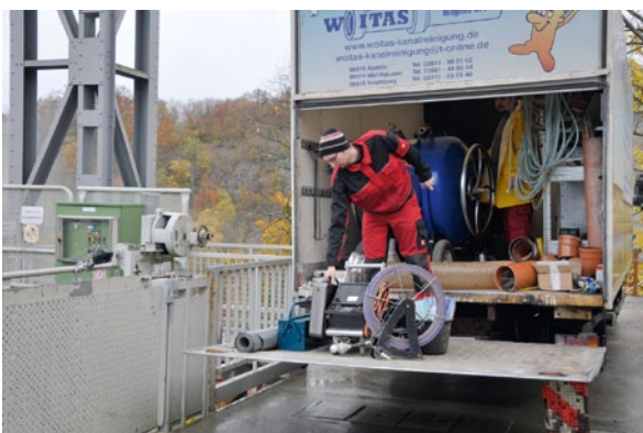
Woitas Rohr- und Kanalreinigung aus Apolda bei der Materialanlieferung.
