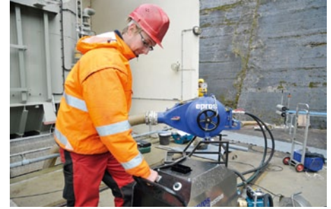
Im Einsatz: Die epros®HWB90 Heißwasseranlage zum Aushärten.
